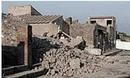
Einsturz des Gladiatorenhauses in Pompeji , Foto: ap
